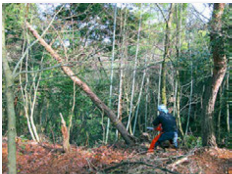
支障木などの伐採
