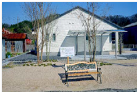
木製ベンチを設置
