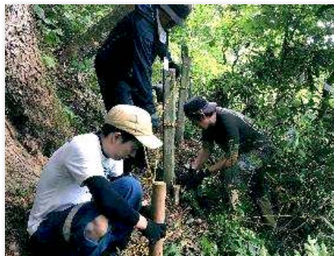
危険個所のロープ付け替え
