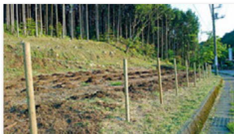
獣害対策のネット設置
