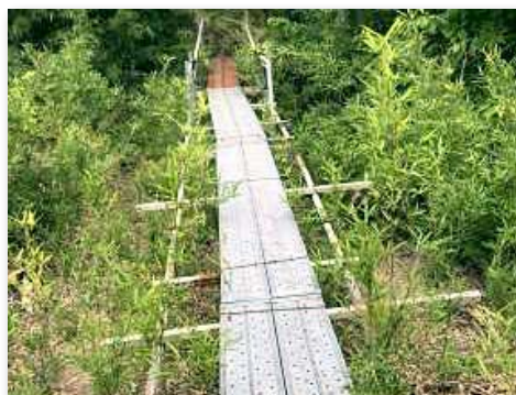
踏板の架け直し
