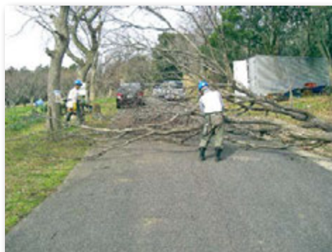
支障木の除去
