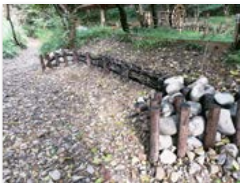
ビオトープ護岸工事(連柴柵と玉石水制工)
