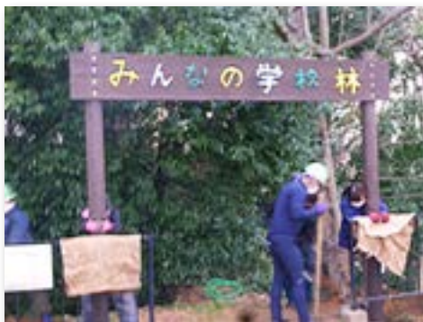
学校林のゲート設置
