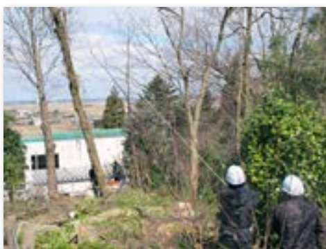
支障木の伐採
