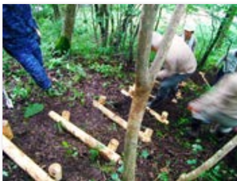
歩道整備(金蔵地区)
