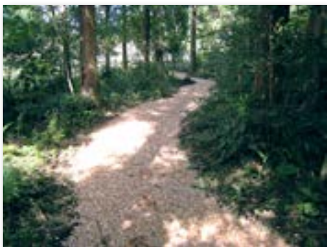
ウッドチップで整備した歩道
