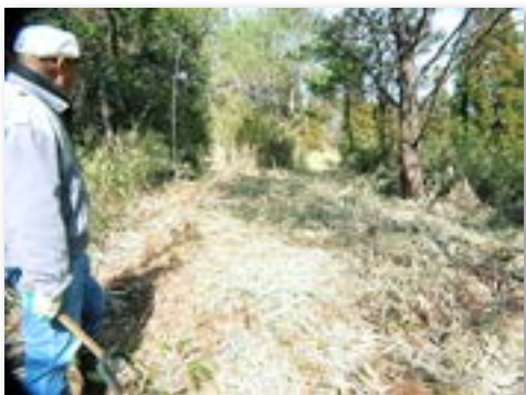
基幹通路の整備
