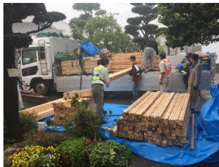
(各地で生産された「組手什」を荷卸し)
